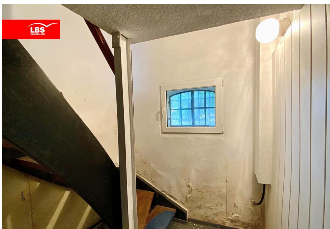
Kelleransicht Treppe nach unten
