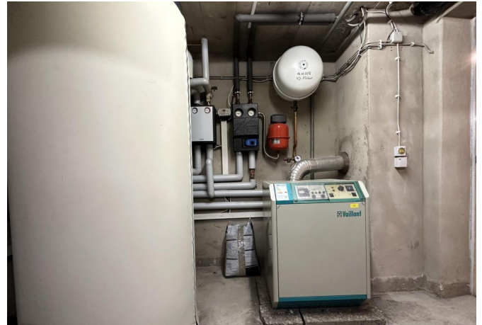
Heizung+Solarspeicher
