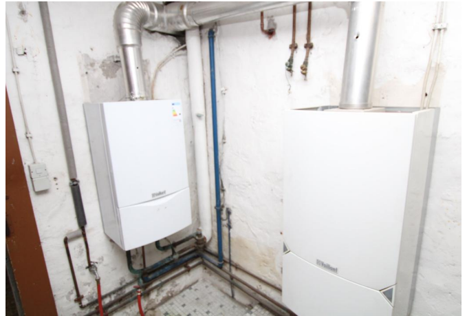
Gasetagenheizung
