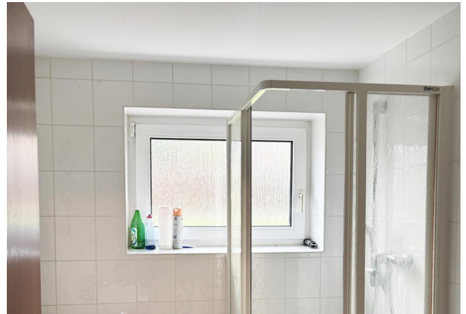
Badezimmer im Keller
